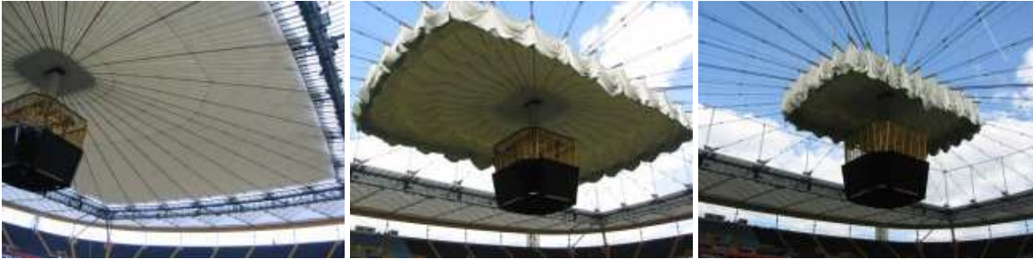
Faltbares Dach, Commerzbank-Arena Frankfurt, Quelle: if-group
